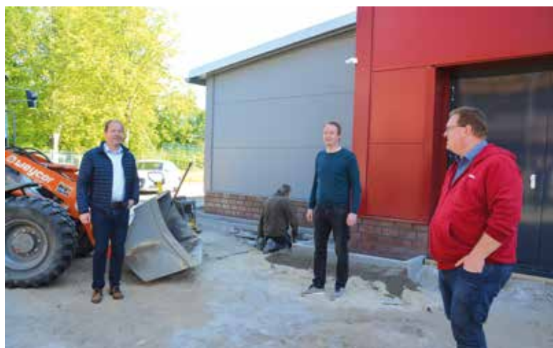
Die abschließenden Außenarbeiten an der neuen Turnhalle der Auburg-Schule in Wagenfeld stehen vor der Vollendung. Das freut (v.r.n.l.) insbesondere Bürgermeister Matthias Kreye, Bauamtsleiter Dennis Härtel und Planer Oliver Keese.
